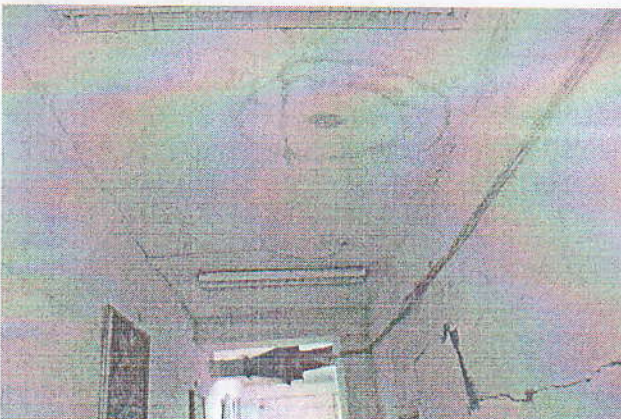
Նկ. 2.2 Տանիքից ներթափանցած մթնոլորտային տեղումների ջրերի ազդեցությունից ծածկերի հավաքովի ե/ք սալերում առաջացած վնասվածքների տեսքերը
