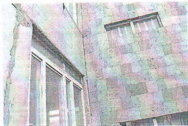
Նկ. 2.11 Հակասեյսմիկ կարանների սխալ լցափակումների տեսքերը դրսից և ներսից
