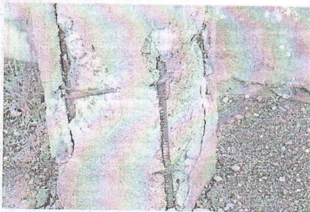
Նկ. 2.9 Հակահրդեհային սանդուղքների և հարթակների ու սյուների վնասվածքների տեսքերը
