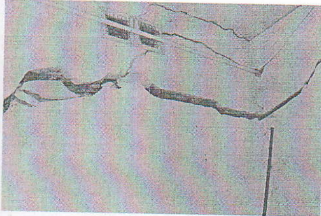
Նկ. 2.4 Ծածկերի սալերի միջև կարանների ուղղությամբ առաստաղի սվաղում առկա ճաքերի տեսքերը
