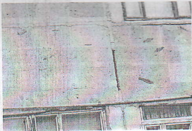
Նկ. 2.10 Պատերի հարակից պանելների միջև կարանների լցափակումների թերությունների և առկա ճաքերի ու վնասվածքների տեսքերը
