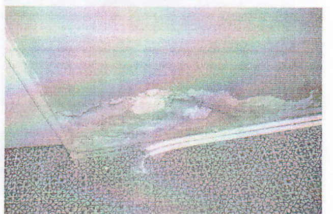
Նկ. 2.3 Մթնոլորտային տեղումների ջրերի ազդեցությունից պատերի պանելներում առաջացած վնասվածքների տեսքերը
