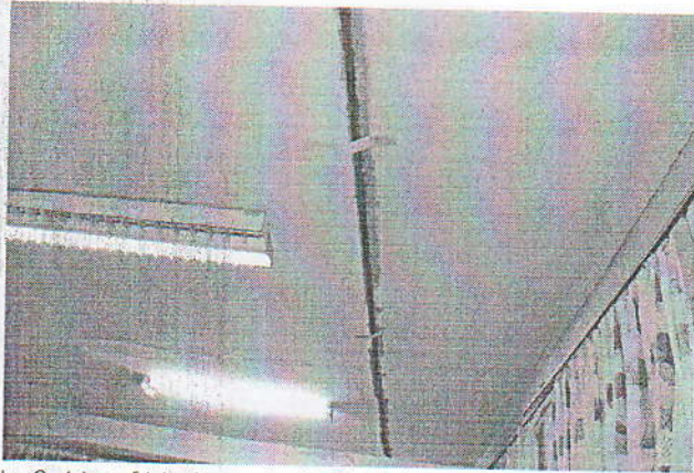
Նկ. 2.4 Ծածկերի սալերի միջև կարանների ուղղությամբ առաստաղի սվաղում առկա ճաքերի տեսքերը
