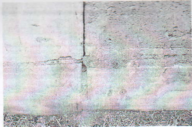
Նկ. 2.10 Պատերի հարակից պանելների միջև կարանների լցափակումների թերությունների և առկա ճաքերի ու վնասվածքների տեսքերը
